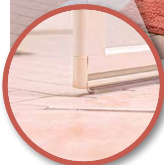
Die alte Wanne ist einer bodenebenen Dusche gewichen.
